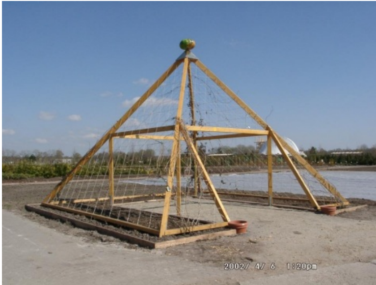
Bau einer Pyramide auf der LGS 2002 in Bad Zwischenahn
